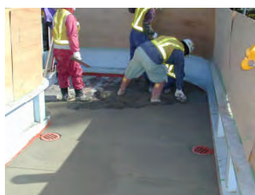
歩道橋床版の打ち換え
