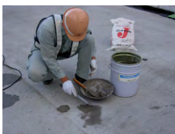
コンクリート舗装の断面補修
