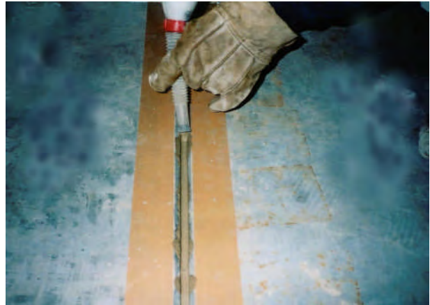
PC版目地材充填状況
