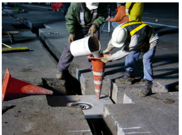
PFG-01 充填状況
