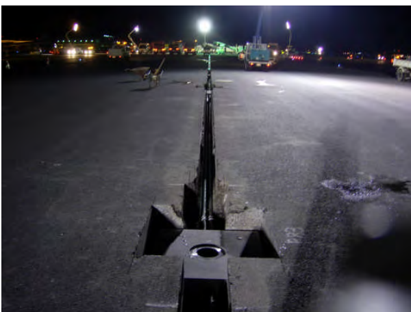
空港滑走路 誘導灯改修
