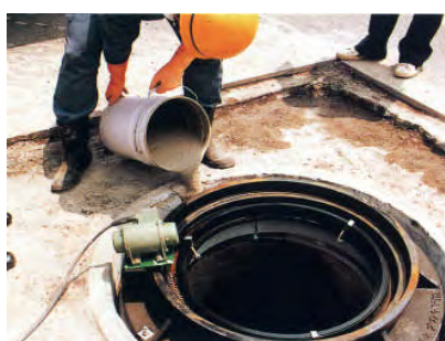
マンホール回り(モルタル)
