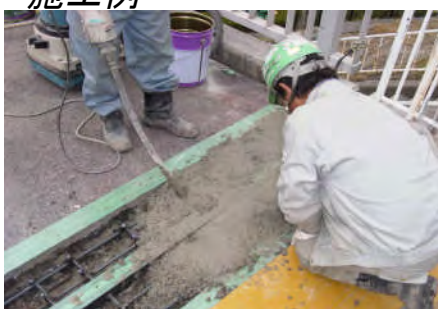
道路橋伸縮継手(コンクリート)
