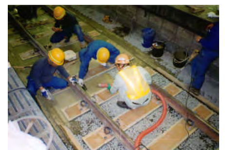
軌道下バラスト補強(グラウト)
